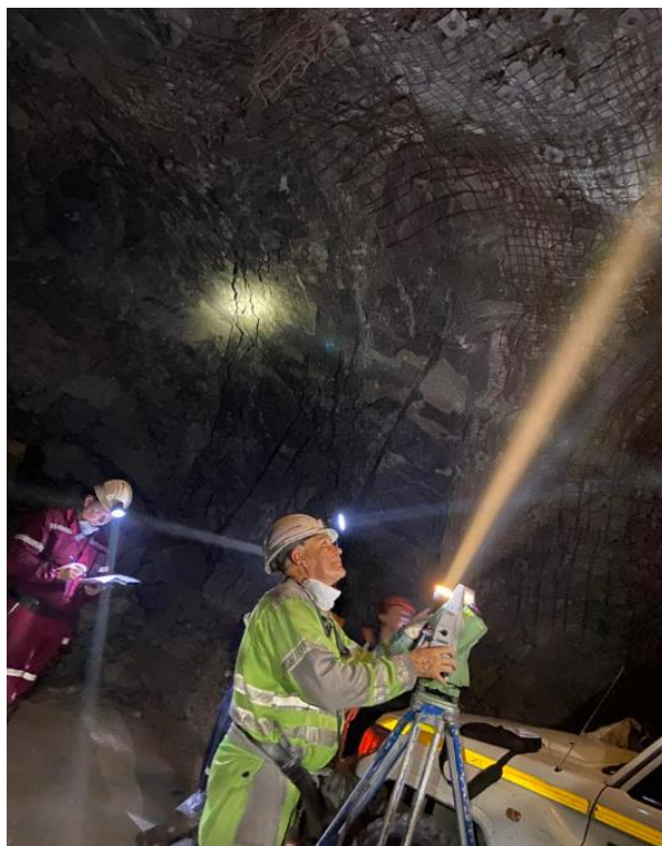
Рисунок 6 - Установка и ориентировка тахеометра.
